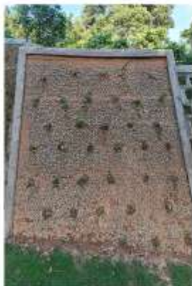
现浇生态混凝土护坡
